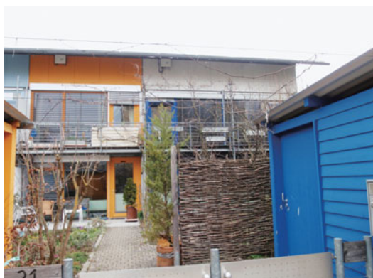
パッシブハウス。壁の厚さは30cmで断熱性が高い
