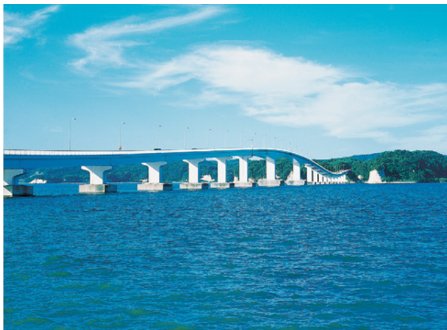
昭和57年(1982)に架けられた能登島大橋。人や車だけでなく飲料水も運ぶ、能登島のライフラインだ
