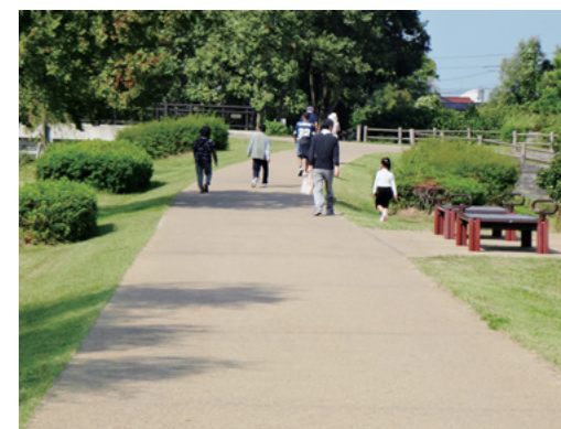
小松市・木場湯公園の瓦舗装
