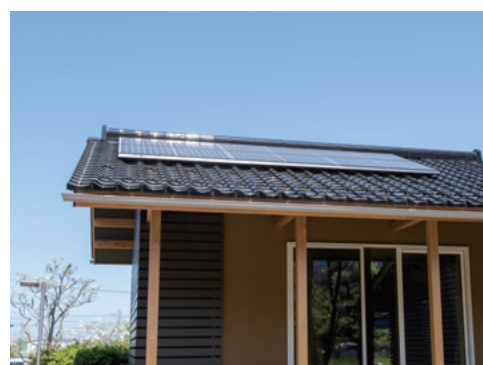
工期短縮などのメリットがある屋根置き型太陽光パネル
