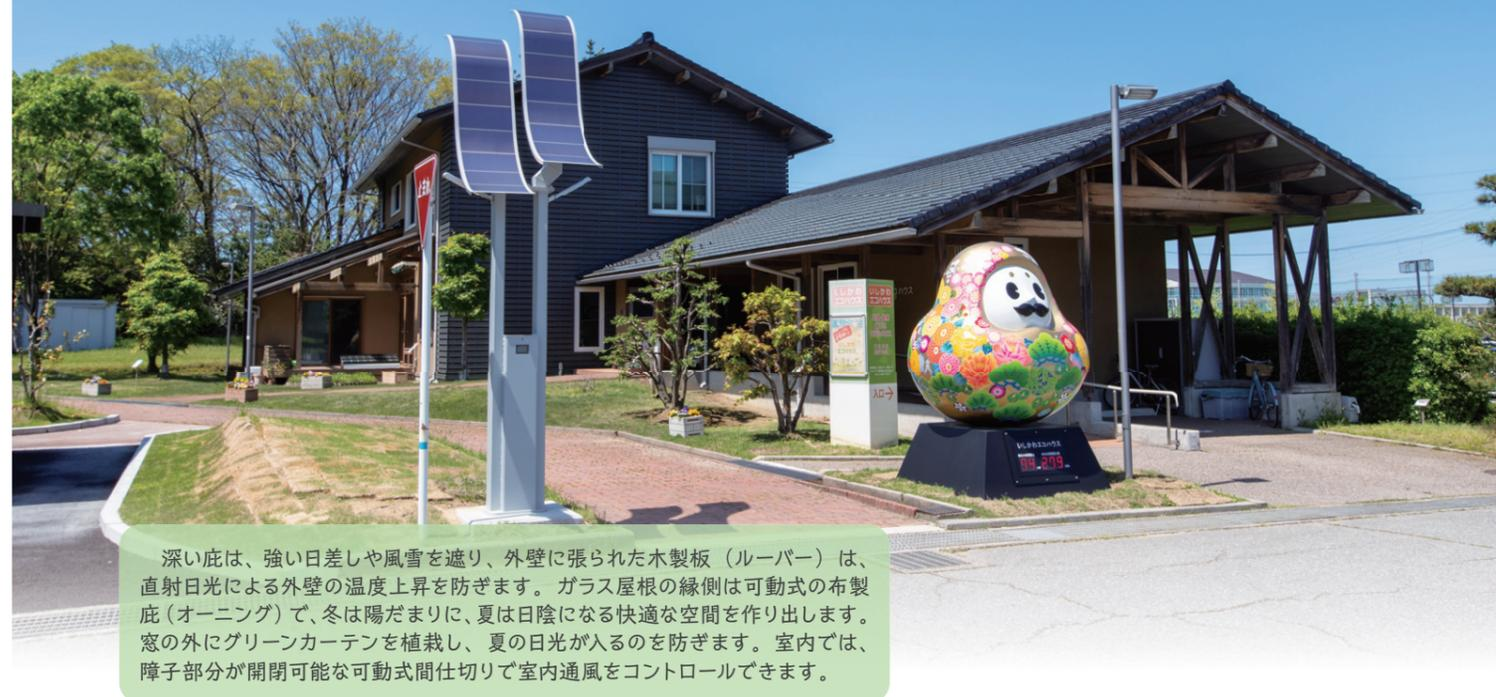
深い庇は、強い日差しや風雪を遮り、外壁に張られた木製板（ルーバー）は、直射日光による外壁の温度上昇を防ぎます。ガラス屋根の縁側は可動式の布製庇（オーニング）で、冬は陽だまりに、夏は日陰になる快適な空間を作り出します。窓の外にグリーンカーテンを植栽し、夏の日光が入るのを防ぎます。室内では、障子部分が開閉可能な可動式間仕切りで室内通風をコントロールできます。
